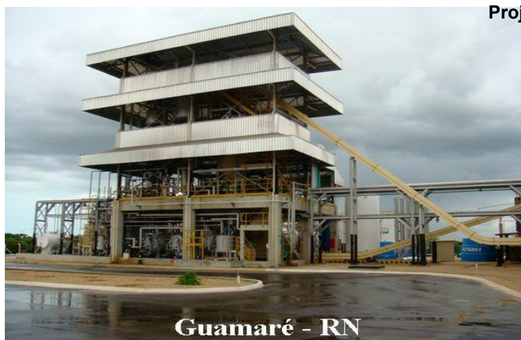
FIGURA 2 UNIDADE DE PRODUÇÃO DE BODIESEL - II DA PETROBRAS - PRODUTORA DA TORTA DE MAMONA PELO PROCESSO DIRETO DA SEMENTE
