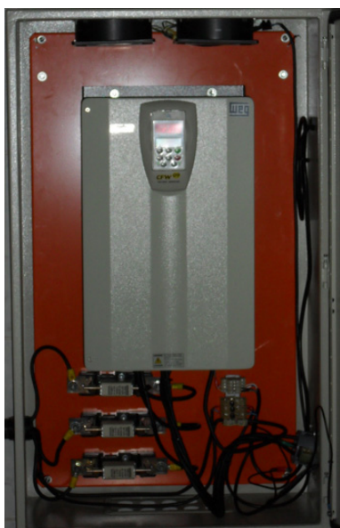
FIGURA 21 INVERSOR DA UNIDADE EXPERIMENTAL
