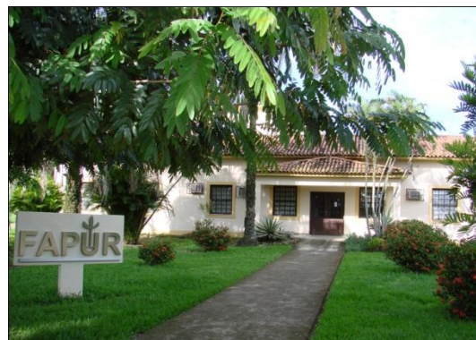
FIGURA 1 SEDE DA FAPUR
